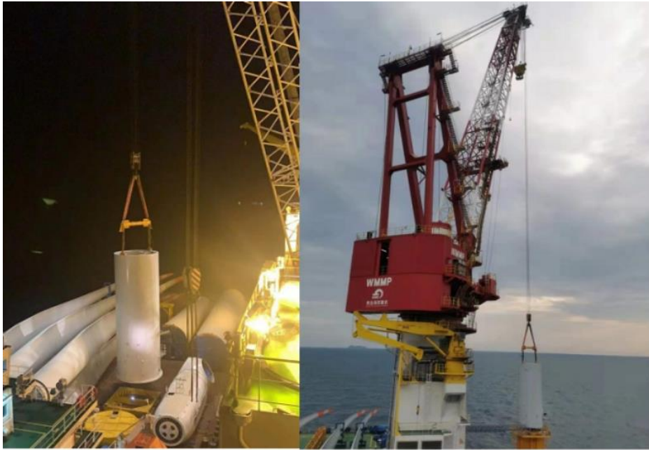
图 2.3.1-12 塔筒吊装
