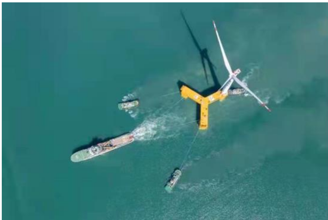
图 2.3.2-4 漂浮式风机整体湿拖运输
