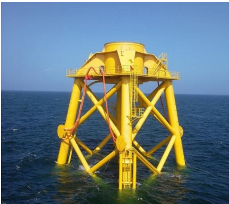
图 2.3.1-9 四桩导管架基础结构示意图
